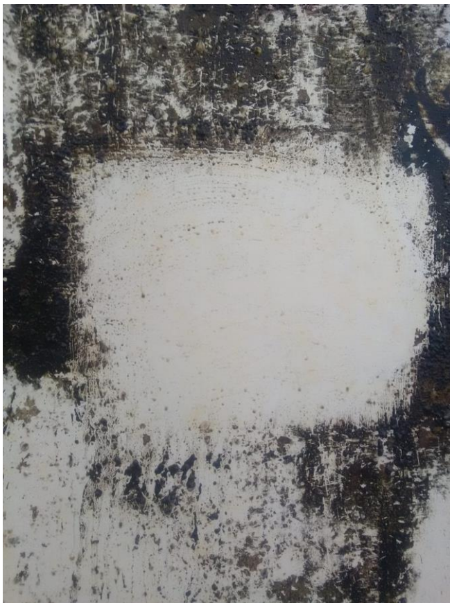
Abb. 45: Nahansicht gereinigte Fläche auf der Stahlplatte, November 2019
