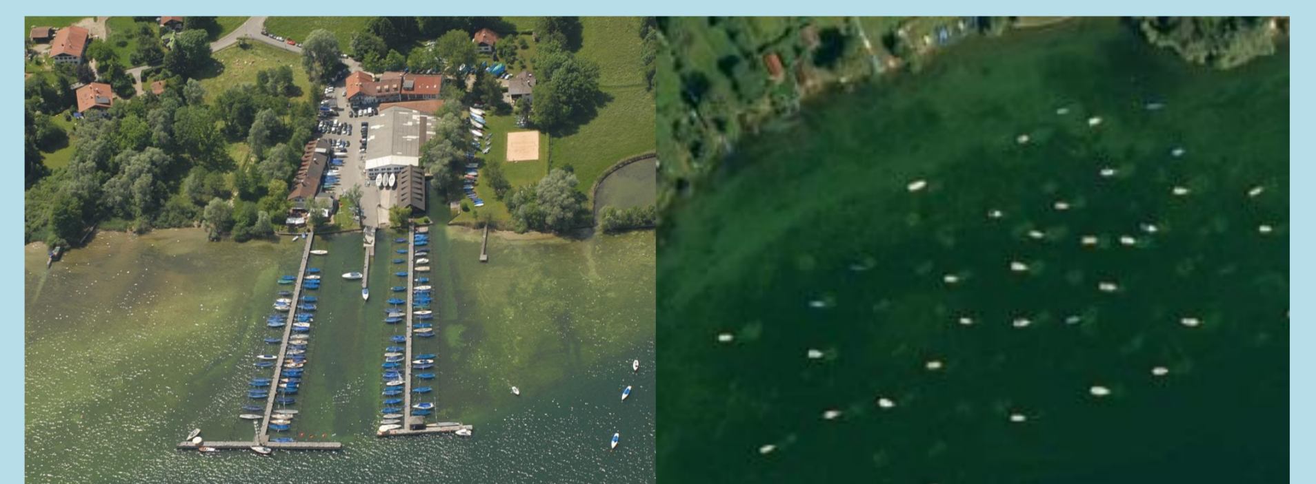
Abb. 4: a. Offene Steganlage, b. Ankerplätze im Bojenfeld
